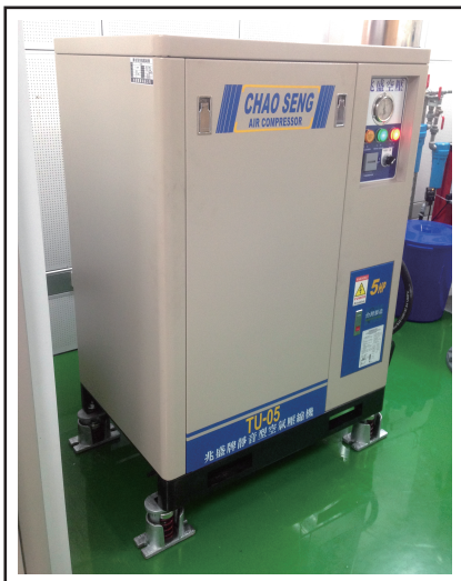
空壓機安裝YS-B彈簧式避振器
