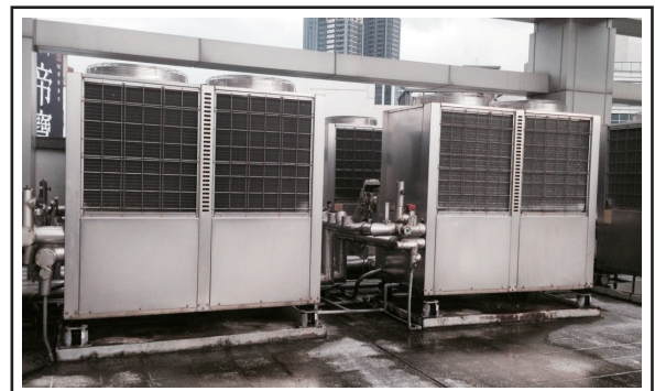
氣冷主機安裝YS-B彈簧式避振器
