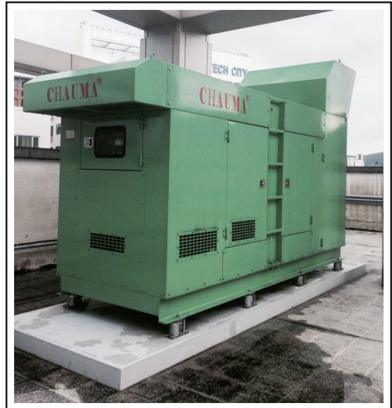
發電機安裝YS-B彈簧式避振器
