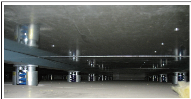
浮動地板安裝YS-B彈簧式避振器
