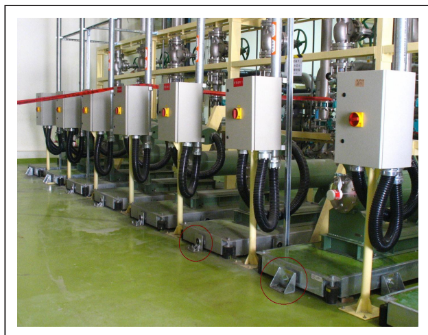
連軸水泵安裝YS-EA橡膠式擊震器
