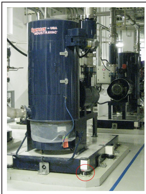
真空機安裝YS-K氣墊式避振器
