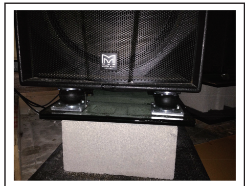
重低音音響安裝YS-K氣墊式避振器
