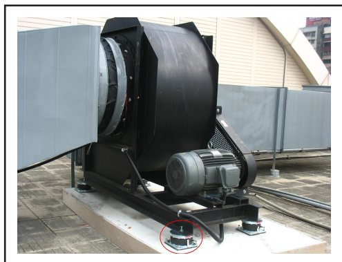
風車安裝YS-K氣墊式避振器
