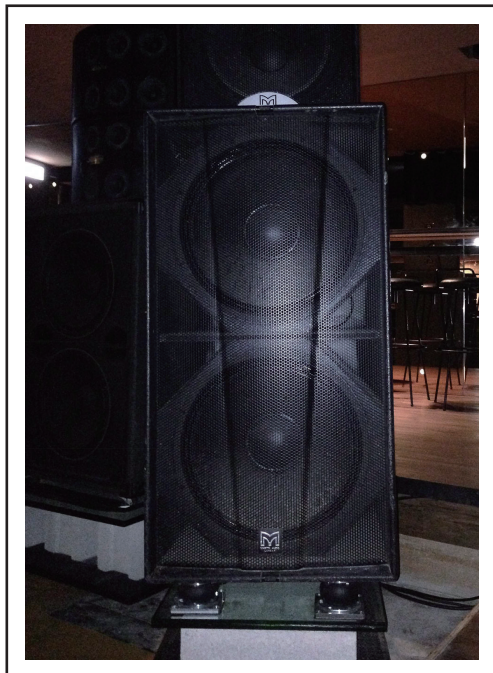
重低音音響安裝YS-K氣墊式避振器
