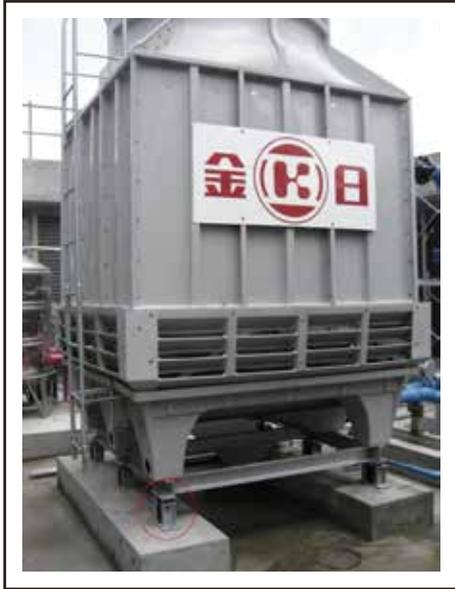
冷卻水塔安裝YS-A彈簧式避振器
