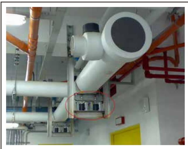
冷卻水管安裝YS-A彈簧式避振器
