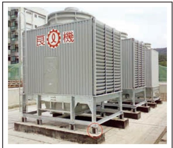
冷卻水塔安裝YS-A彈簧式避振器
