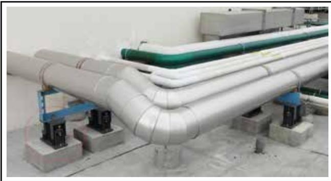
水平管安裝YS-AG抗地震型彈簧式避振器
